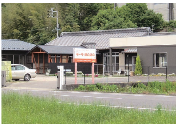
古民家をリフォームしたサーラほのぼの外観
