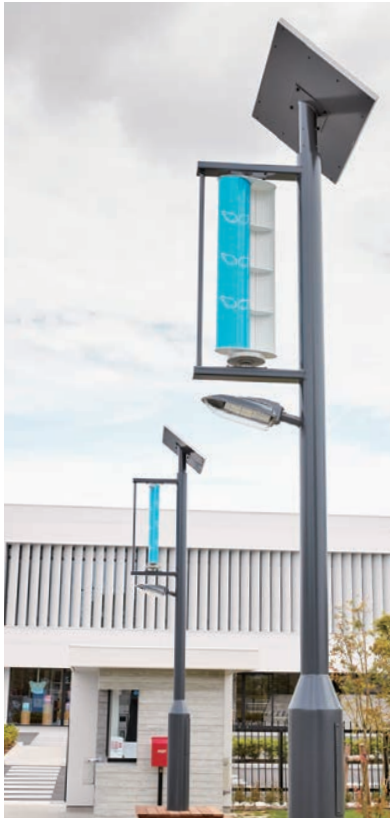
新工場の外灯は風力発電と太陽光発電で点灯
